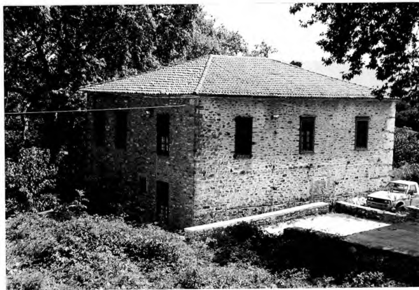
Το κτίριο του πρώην Παρθεναγωγείου του Μεταξοχωρίου όπως είναι σήμερα μετά την αναπαλαίωση που του έγινε [φωτογραφίες Στέργιος Γ. Τάτσιος (2004)]
