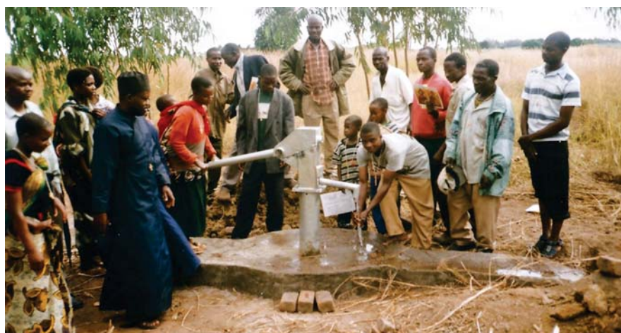
Γεώτρηση ἀντήλησης πόσιμου νεροῦ στὸ Μαλάουι
