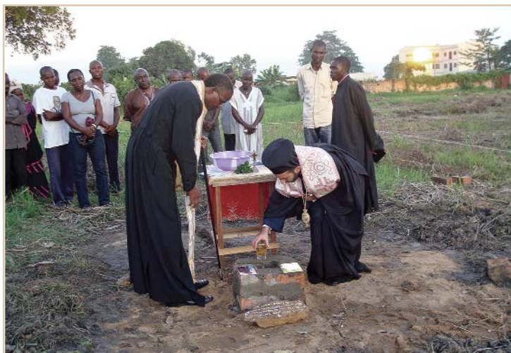
Θεμελίωση του Ναού των Τιμίου Προδρόμου καί Ἁγίου Νικολάου
