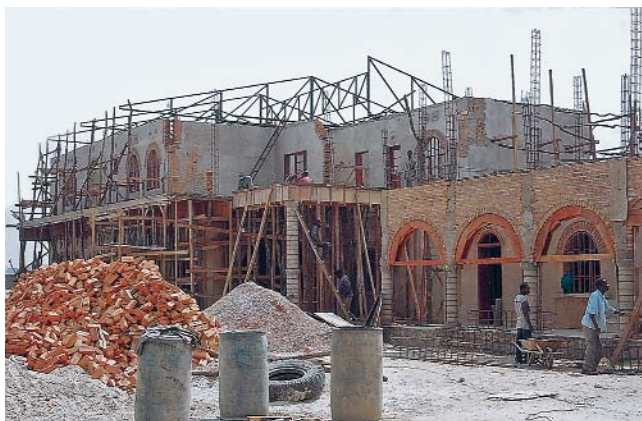
Ἡ ὑπό κατασκευὴ νοσοκομειακὴ μονάδα στὸ Κολλοῦζι τῆς Ἱερᾶς Ἐπισκοπῆς Κατάνγκας
