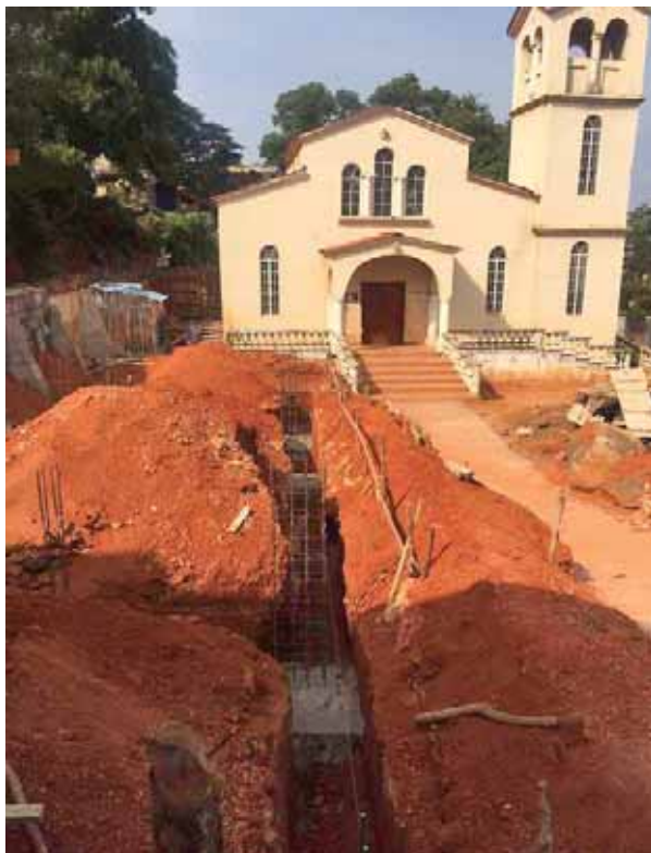
Ἀπό τίς ἐργασίες διάνοιξης τῶν θεμελίων τοῦ Ὀρφανοτροφείου στόν περιβάλλοντα χώρο τοῦ Ἱ. Ν. Ἁγ. Κων/νου καί Ἑλένης Tower Hill
