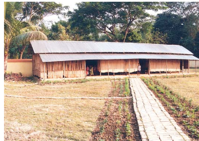
Δημοτικὸ σχολεῖο. Στὸ ἴδιο οἰκόμεδο οἰκοδομεῖται νέο διώροφο κτίριο.
