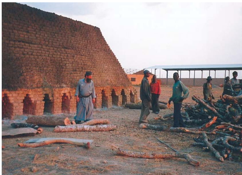
Κογκό. Καμίνι για κατασκευή τούβλων, που θα χρησιμοποιηθούν σε ανέγερση ναών.
